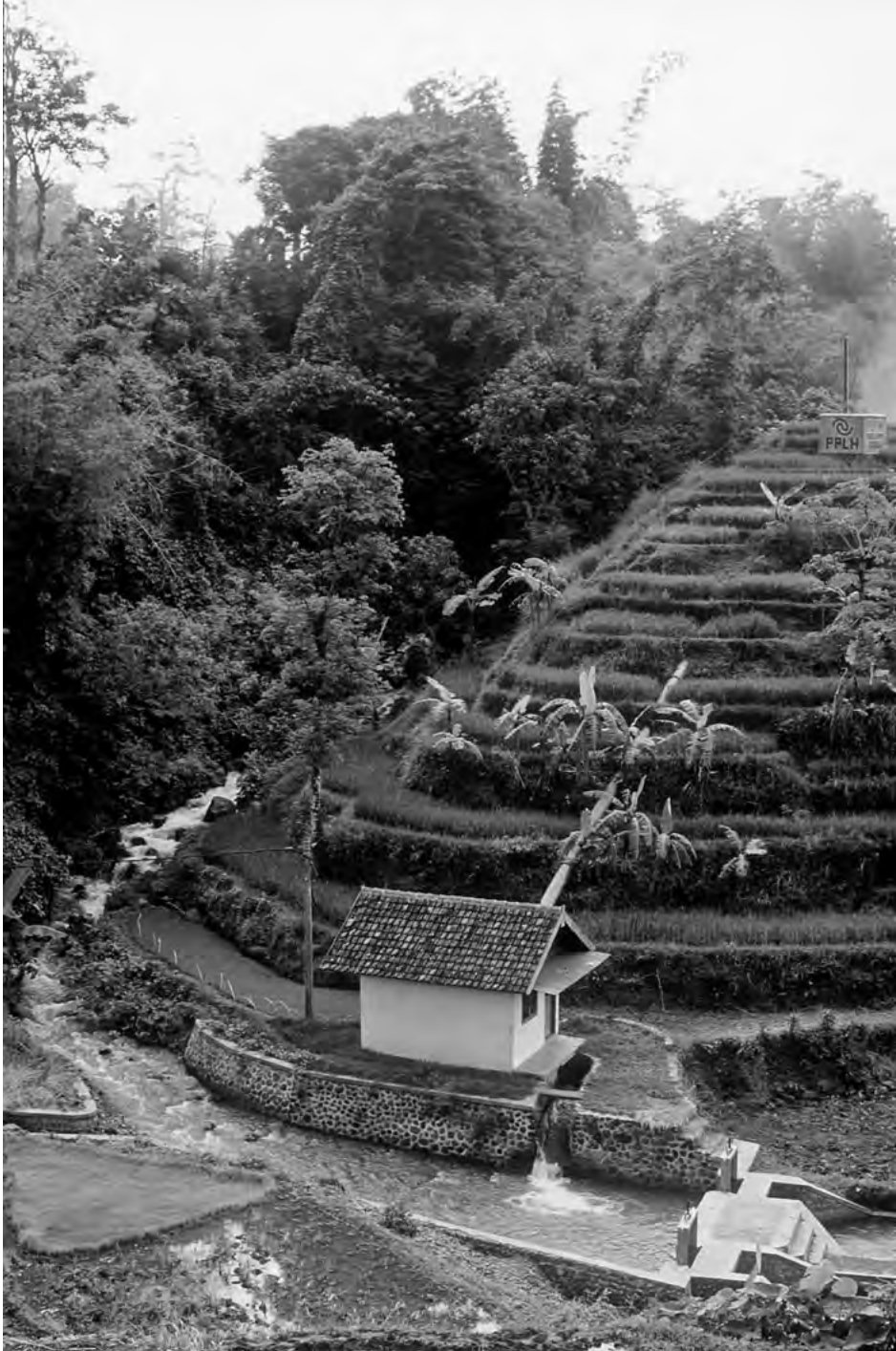
Mini-Wasserkraftwerk zur Energieerzeugung in einem Dorf auf Java
